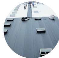
Revêtements d'étanchéité de toit
