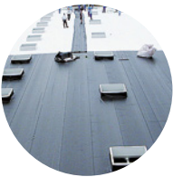
Revêtements d'étanchéité de toit
